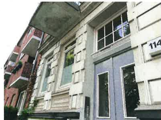
Bossenputzfassade im EG
