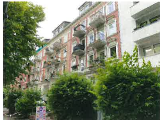
Fassadenausschn. mit Nachbar 108 (WDVS)
