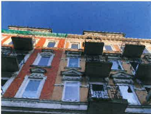
Fassadenausschnitt (Abnetzung an Dach)
