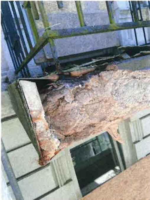
Balkonplatte mit umlauf. Blechverkleidung
