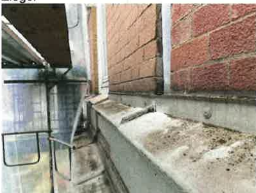
Gesims mit Blech im 1.OG
