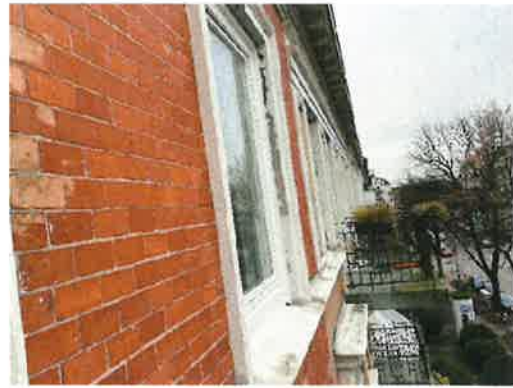
Fassade mit Fenster im 3.OG, Nr. 114
