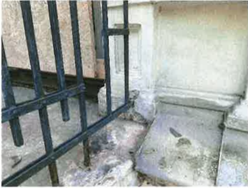
Balkongeländer in Nr. 110, 1.OG links
