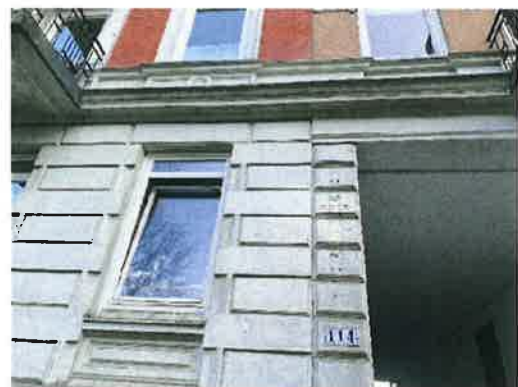
Quaderfassade mit Durchfahrt
