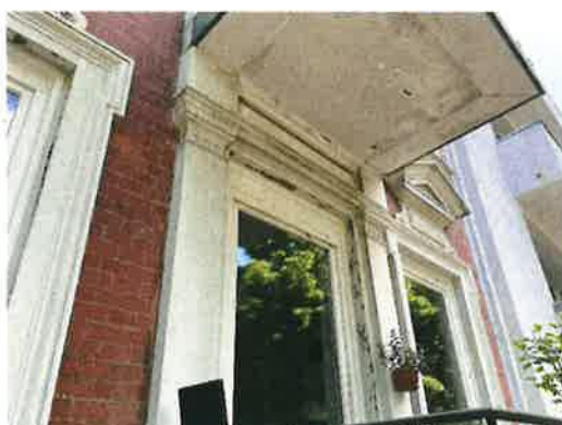
Fassadendetail Balkon Nr. 110
