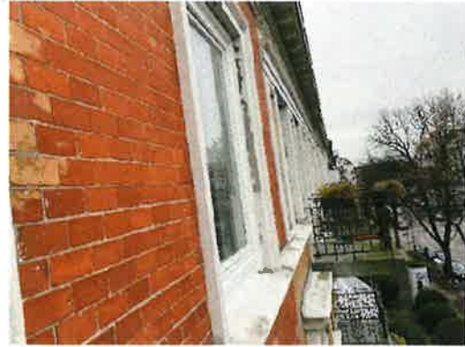
Fassade mit Fenster im 3.OG, Nr. 114
