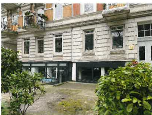
Straßenansicht, mit Läden im Souterrain
