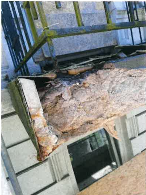
Balkonplatte mit umlauf. Blechverkleidung
