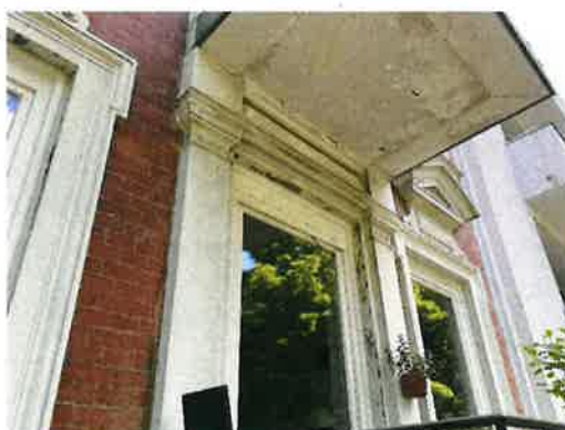
Fassadendetail Balkon Nr. 110
