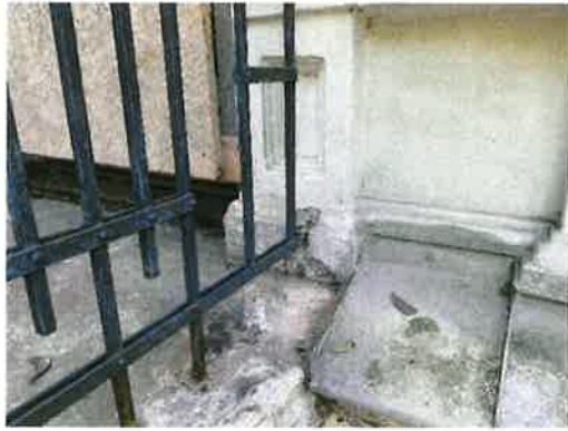
Balkongeländer in Nr. 110, 1.OG links
