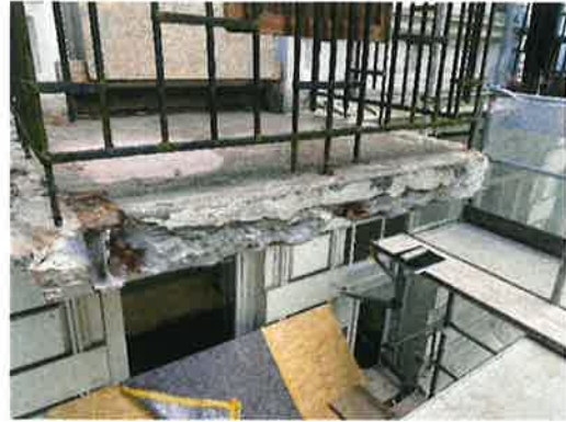
Balkonplatte mit freigestemmen Trägern
