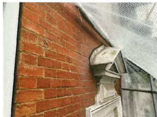
Spitzüberdachung über Fenster
