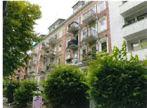
Fassadenausschn. mit Nachbar 108 (WDVS)
