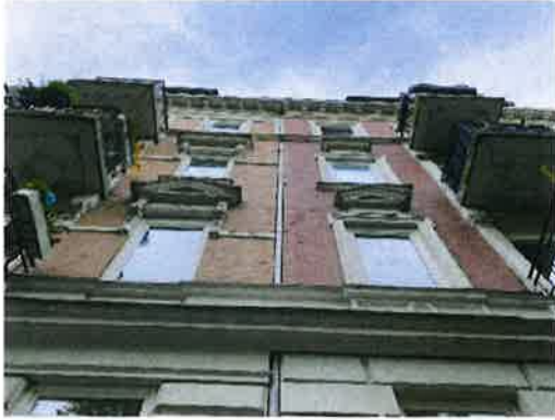
Bauteillfuge zw. Haus 110 und 112
