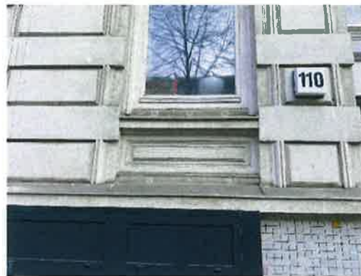
Quaderfassade (Parterre)
