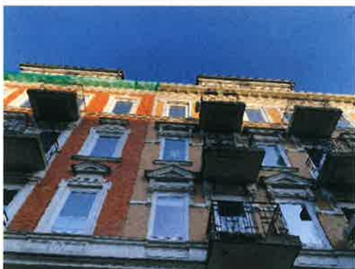
Fassadenausschnitt (Abnetzung an Dach)
