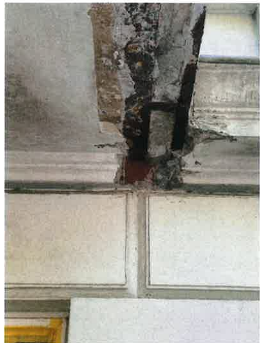
Balkonuntersicht mit seilt. Verreiterung
