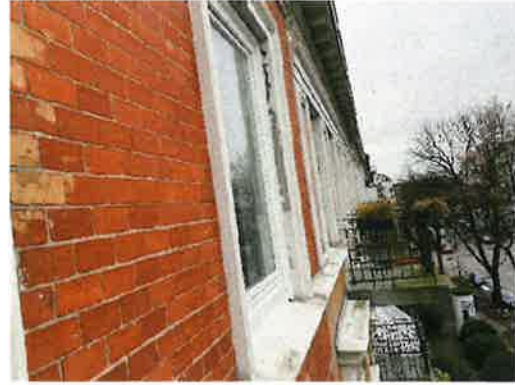
Fassade mit Fenster im 3.OG, Nr. 114
