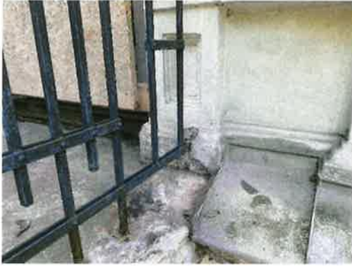
Balkongeländer in Nr. 110, 1.OG links
