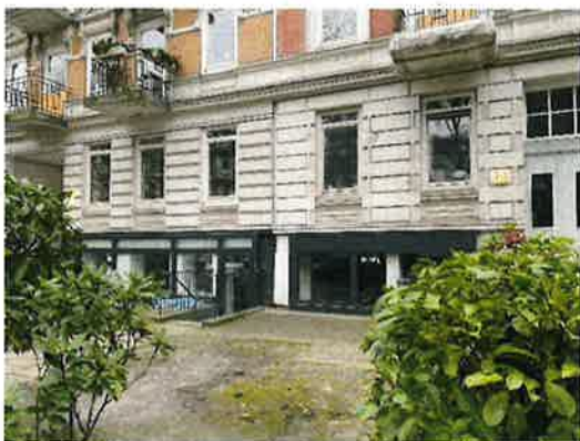
Straßenansicht, mit Läden im Souterrain
