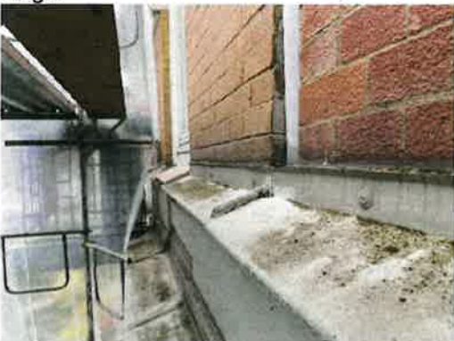
Gesims mit Blech im 1.OG
