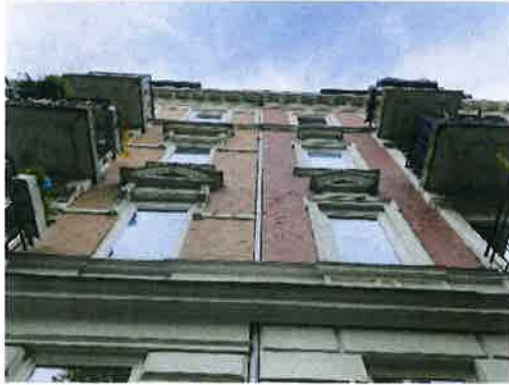
Bauteillfuge zw. Haus 110 und 112
