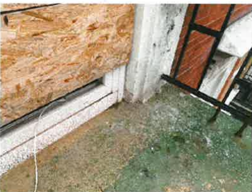
Balkontür Fußpunkt am Balkon
