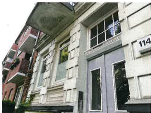
Bossenputzfassade im EG
