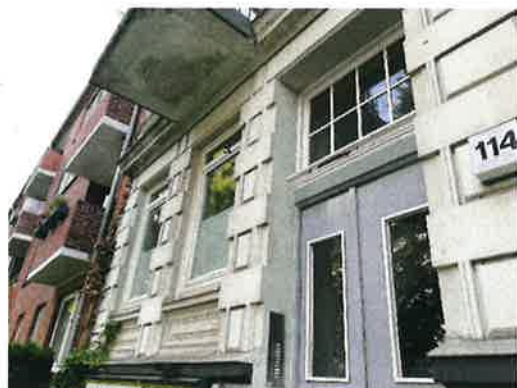
Bossenputzfassade im EG
