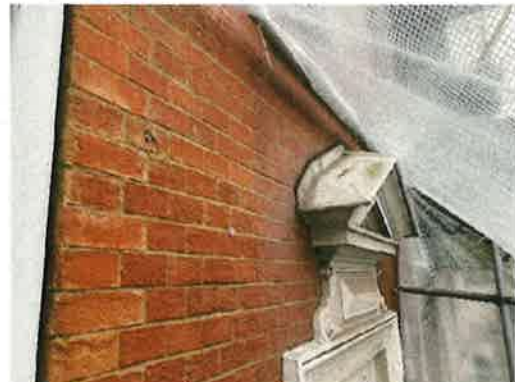
Spitzüberdachung über Fenster
