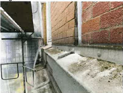
Gesims mit Blech im 1.OG
