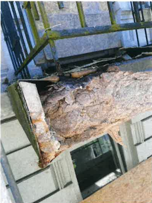
Balkonplatte mit umlauf. Blechverkleidung
