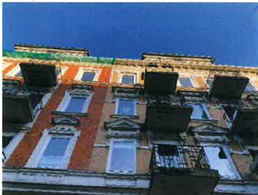
Fassadenausschnitt (Abnetzung an Dach)
