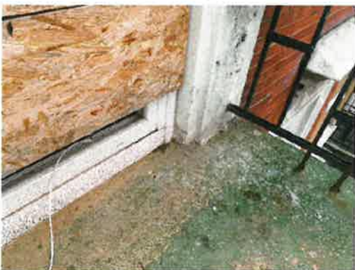
Balkontür Fußpunkt am Balkon
