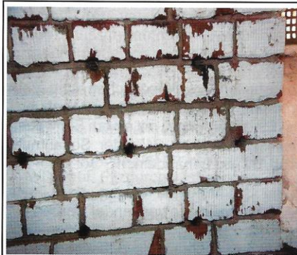
Abb. 33: Anordnung der Bohrlöcher bei einer drucklosen Mauerwerksbehandlung. Der Bohrkanal soll vorzugsweise in der Fuge beginnen und hat mindestens zwei Lagerfugen zu durchstoßen.
