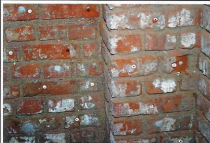
Abb. 34: Anordnung der Bohrlöcher bei einer Bohrlochdrucktränkung mit Schraub- und Einwegpacker (Foto nur Einwegpacker). Der Bohrkanal soll vorzugsweise im Ziegel beginnen und hat mindestens eine Fuge zu durchstoßen.
