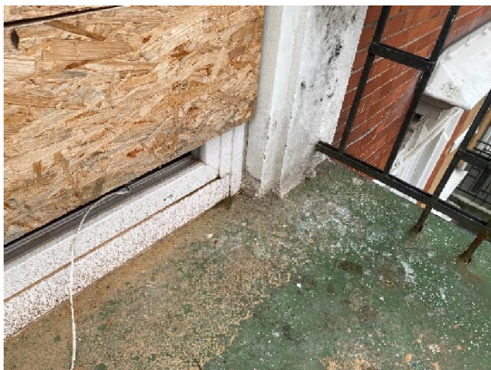
Balkontür Fußpunkt am Balkon
