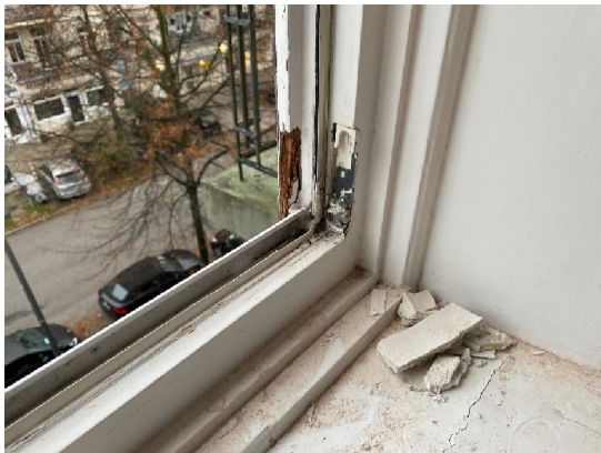
Bestandsfenster mit hölz. Leibung
