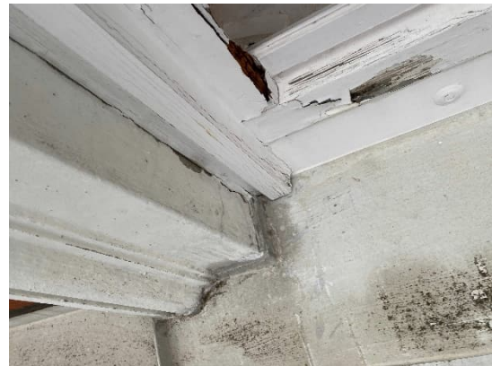
Bestandsfenster mit Fensterbankblech (außen)
