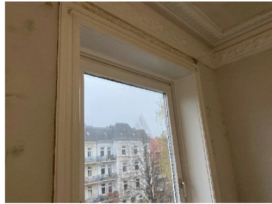
Bestandsfenster mit hölz. Leibung
