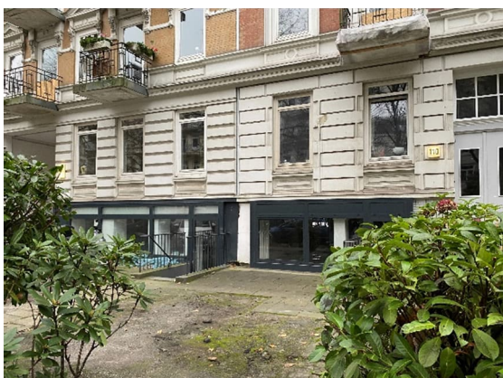
Straßenansicht, mit Läden im Souterrain
