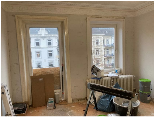
Bestandsfenster in Nr. 114, 3.OG rechts
