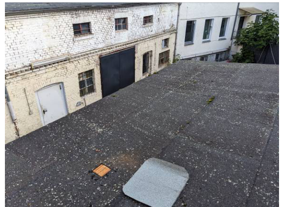
Foto 12: DÖ3 - Dach Haus 2 - Carport
