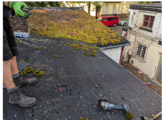
Foto 6: DÖ2 - Dach Haus 2
