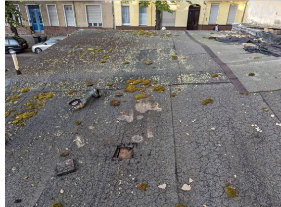
Foto 2: DÖ1 - Dach Haus 1
