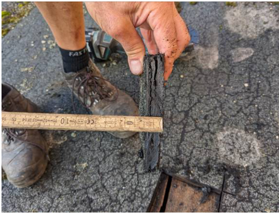
Foto 3: P17 – DÖ1 - Dachabdichtung - Haus 1
