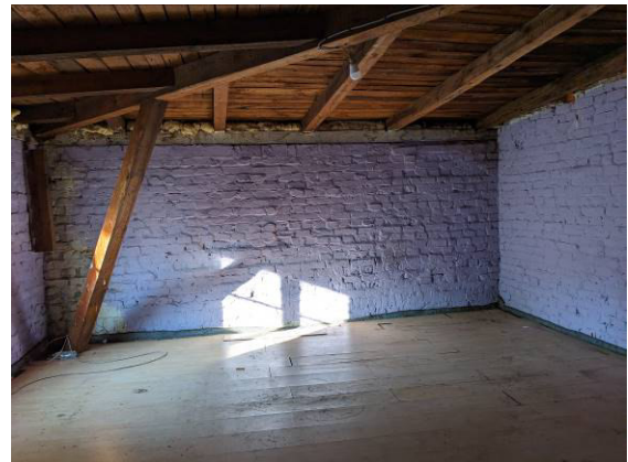
Foto 4: P1 - Holz Dachkonstruktion - Haus 1 - 1.OG
