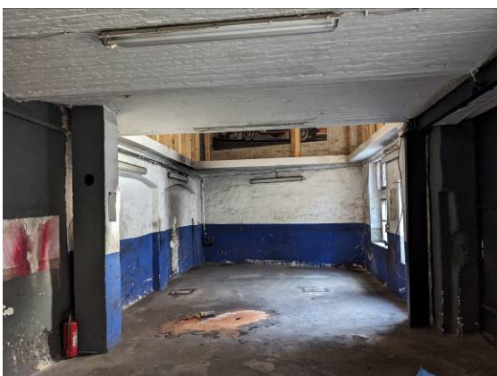
Foto 17: BK1 - FuBo Halle - EG - Haus 1
