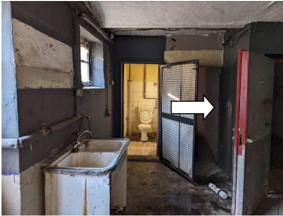
Foto 19: BK2 – Wand Kühlraum – EG – Haus 1
