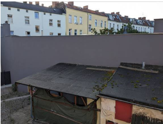
Foto 11: Dach Haus 2 - Carport
