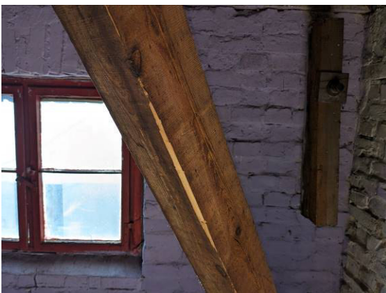
Foto 5: P1 - Holz Dachkonstruktion - Haus 1 - 1.OG
