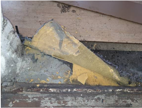
Foto 7: P2 - Teppichkleber - Haus 1 - 1.OG
