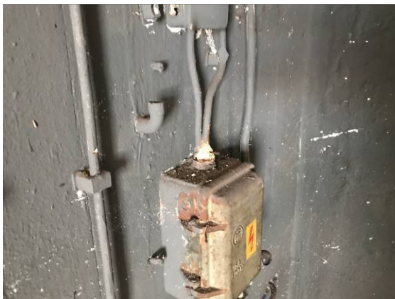
Foto 15: P9 - Gurukitt Elektrokasten - Haus 1 - EG
