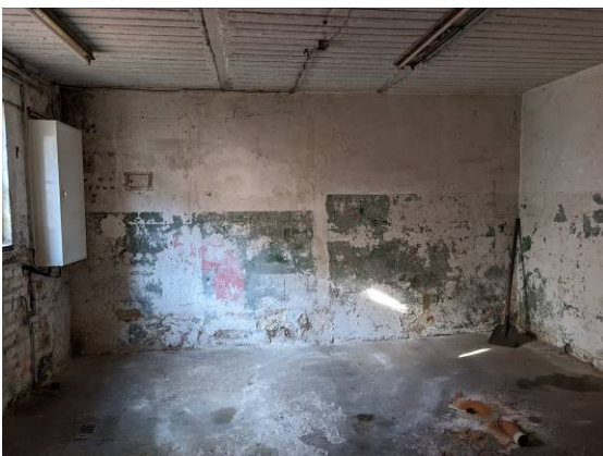
Foto 23: BK4 – FuBo Lagerraum – EG – Haus 1
