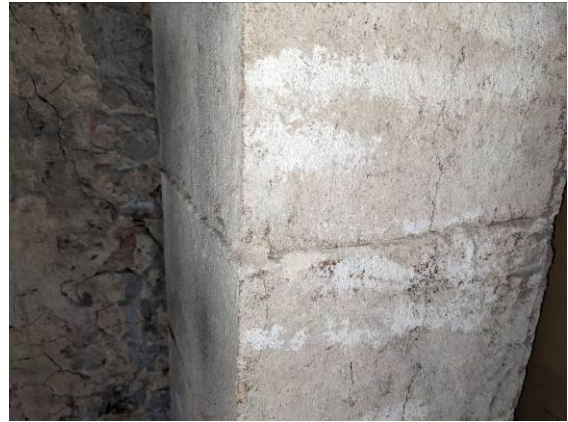
Foto 8: P3.1 - MP Putz Schornstein - Haus 1 - 1.OG - Schornsteinfuge
