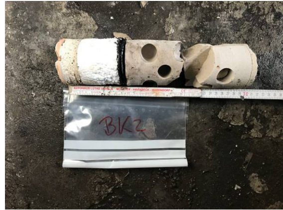
Foto 20: P12 - BK2 - Styropor Wand & P13 - BK2 - Schwarzabdichtung Wand
