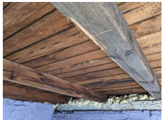
Foto 6: P1 - Holz Dachkonstruktion - Haus 1 - 1.OG
