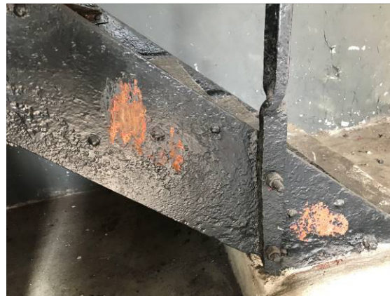
Foto 14: P8 - Farbe schwarz Treppe - Haus 1 - EG
