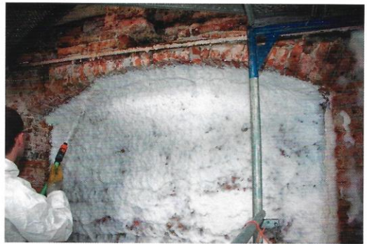
Abb. 32: Schaumauftrag auf der Mauerwerksoberfläche im Bereich einer Nische.
